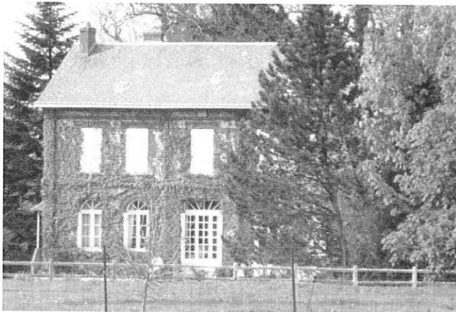
*Construites dans la seconde partie du XIX<sup>e</sup> siècle, ce sont des constructions à double corps à la façade ordonnancée, issue des traités d'architecture du XVIII<sup>e</sup> siècle, les chaînes et les nervures sont en brique et sa « tapisserie » en moellons enduits.*
