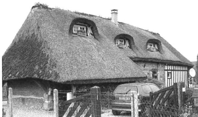
*Constructions à pans de bois avec colombes apparentes verticales et serrées, hourdées de torchis recouvert d'enduit blond ocré. Toiture végétale en chaume avec « queue de geai » abritant l'échelle de meunier. Faîtage en terre planté d'iris, de sédum et de jubarbe.*
